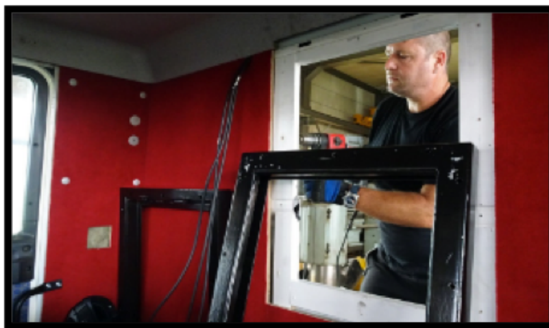
Mike en train de finaliser le portillon d'accès entre camion et cellule
